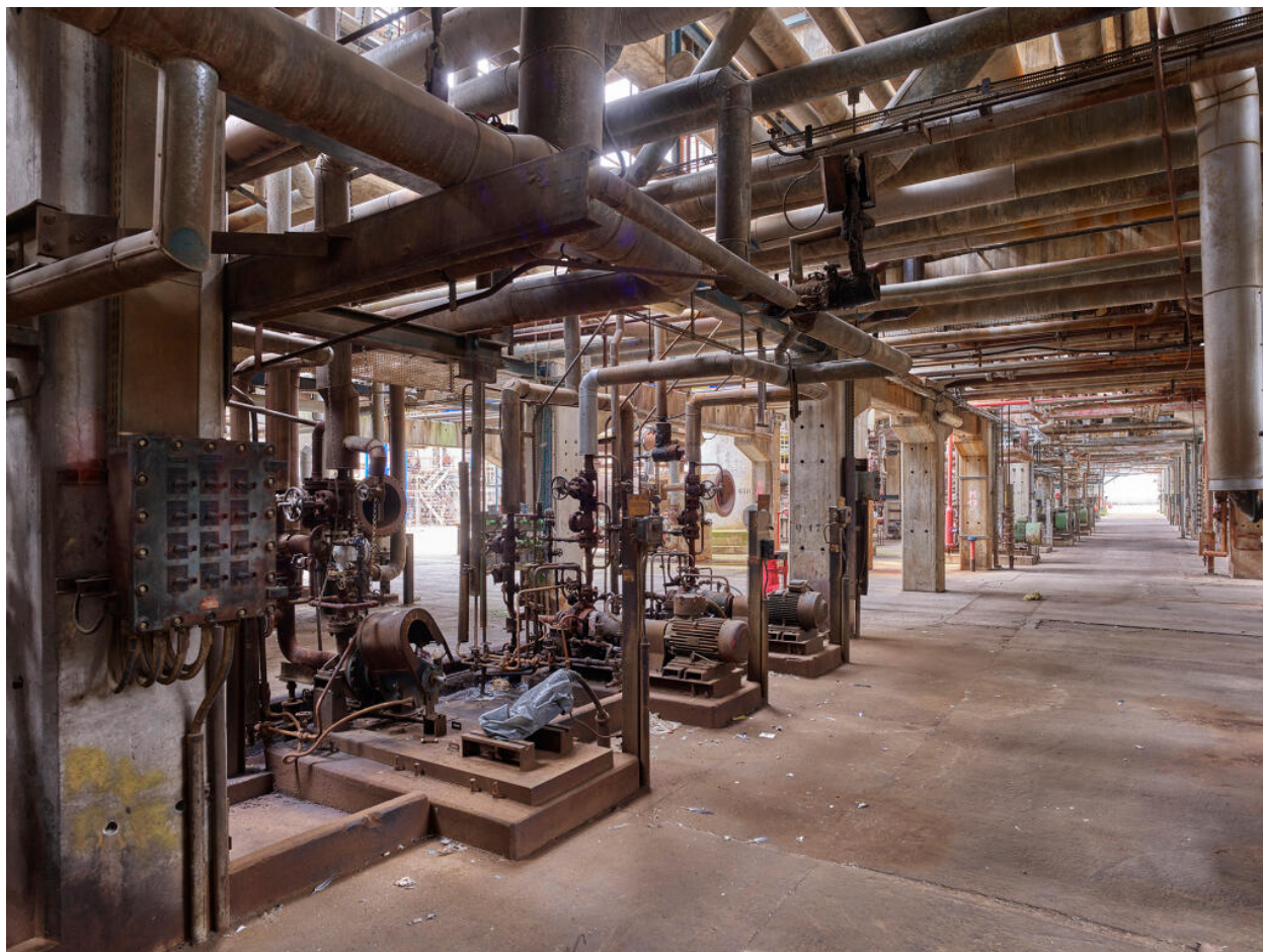
Unités Est - Zone FCC (Unité 651). Allée centrale du FCC avec vue sur les racks et à gauche, les pompes. En cours de démontage.
