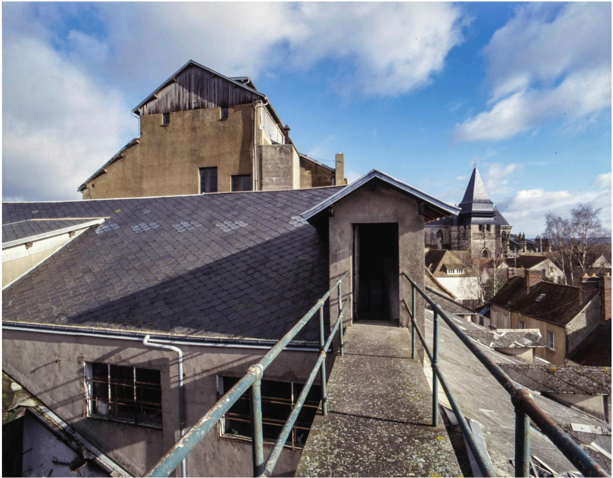
Vue des toitures vers le bâtiment principal, depuis la passerelle conduisant à la grande citerne.
