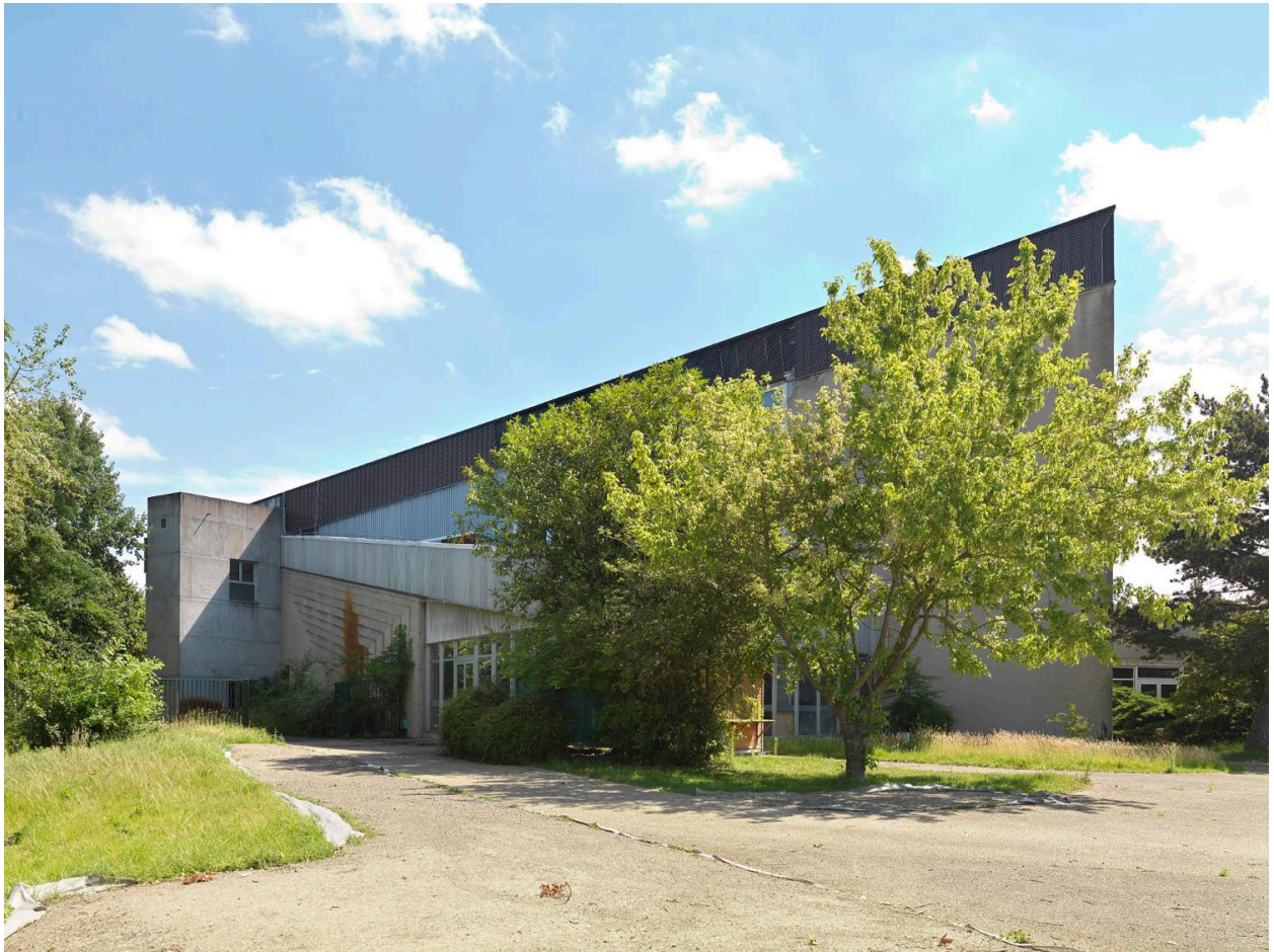
Elévations ouest de la piscine prises depuis les anciens terrains des tennis.
