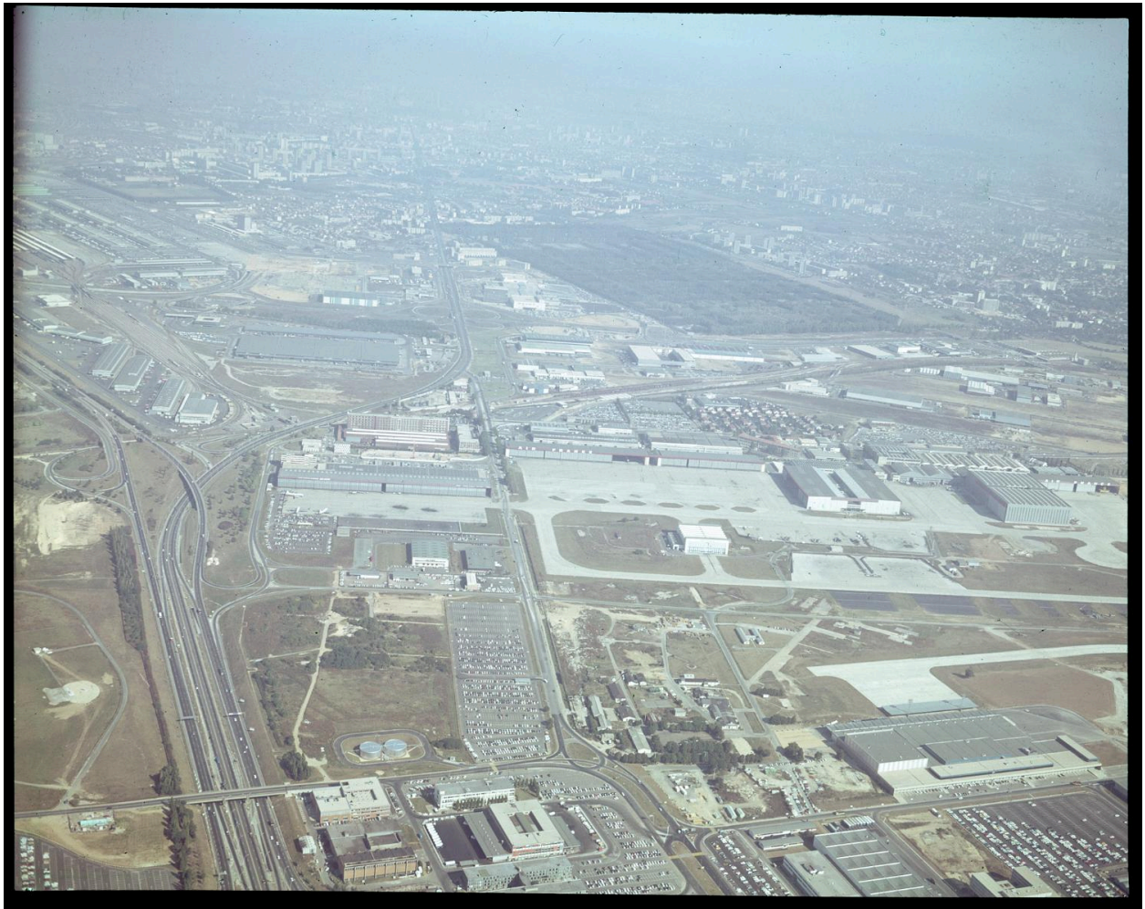
Vers 1971, zone nord de l'aéroport d'Orly vue depuis le sud ouest.
