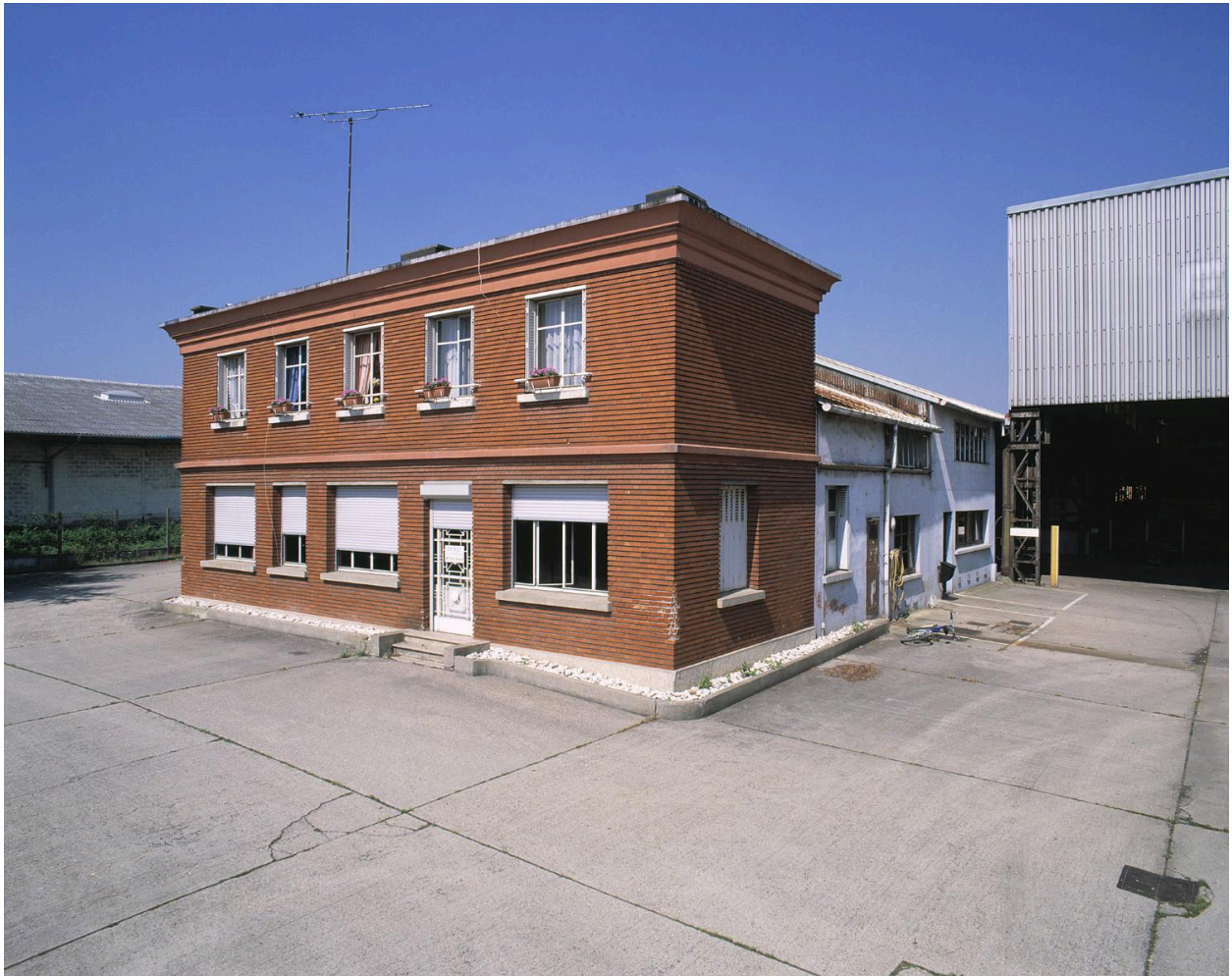
Etablissements Champion : vue d'ensemble du bâtiment à usage de logement, bureaux et garages construit en 1950.
