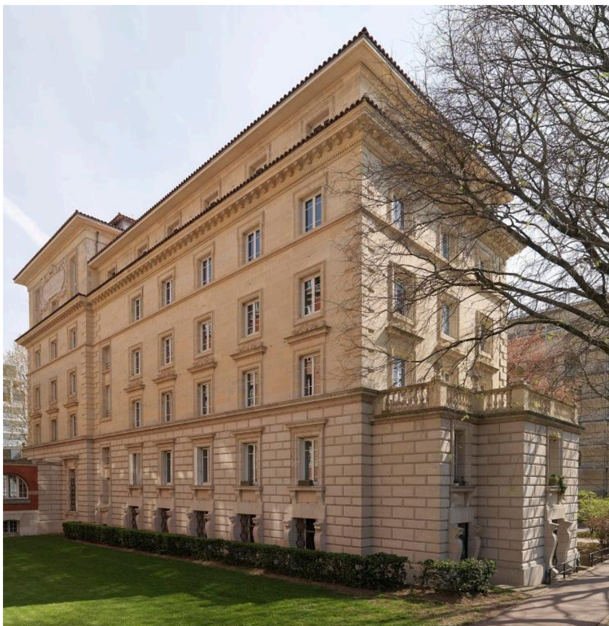
Vue d'ensemble, côté parc : façades ouest et sud.
