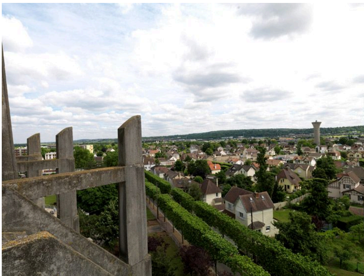
Système de contrebuttement de l'église.
