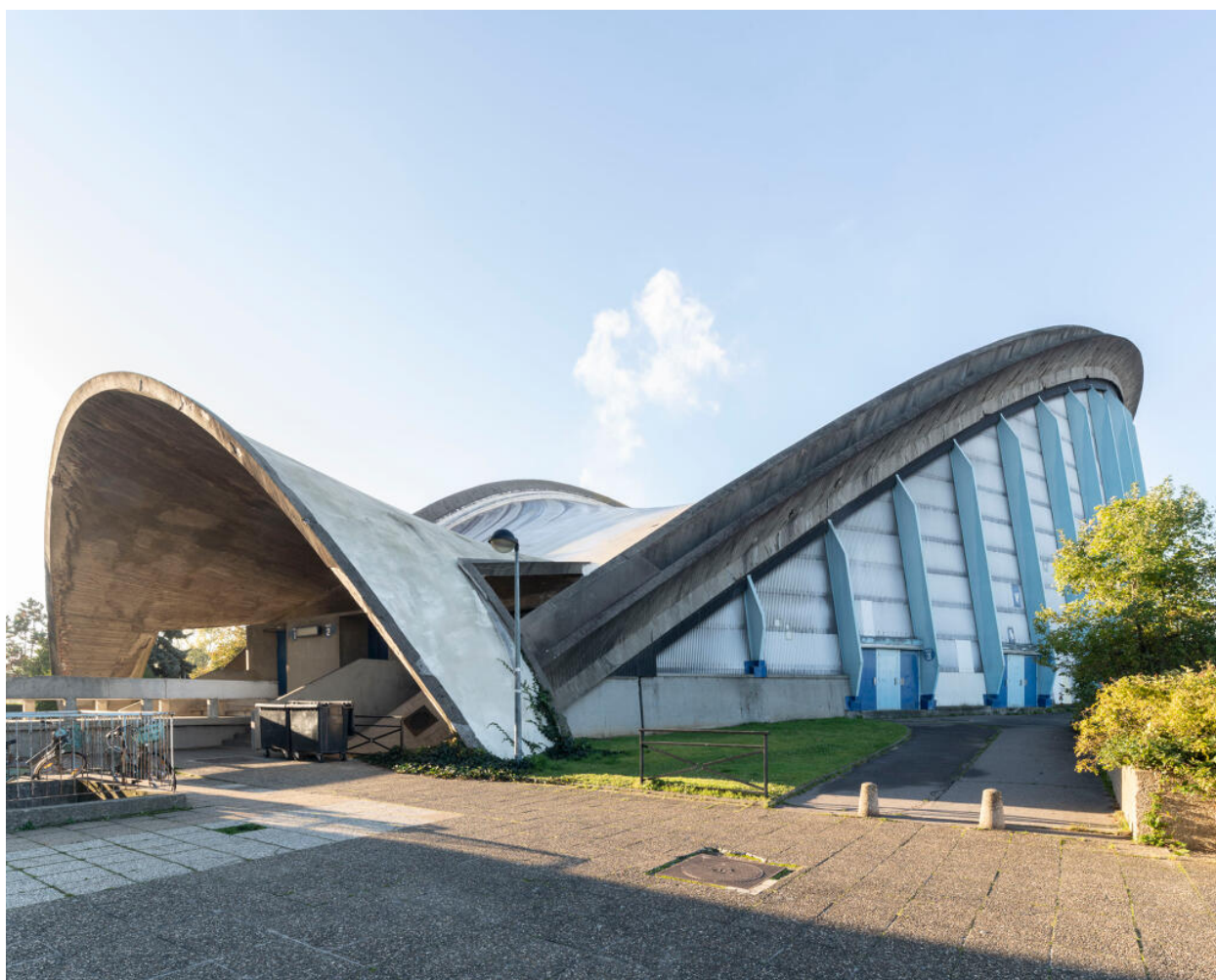
Grande Nef Lucien Belloni, dite Grande Nef de l'Île-des-Vannes avant travaux. Vue extérieure large.
