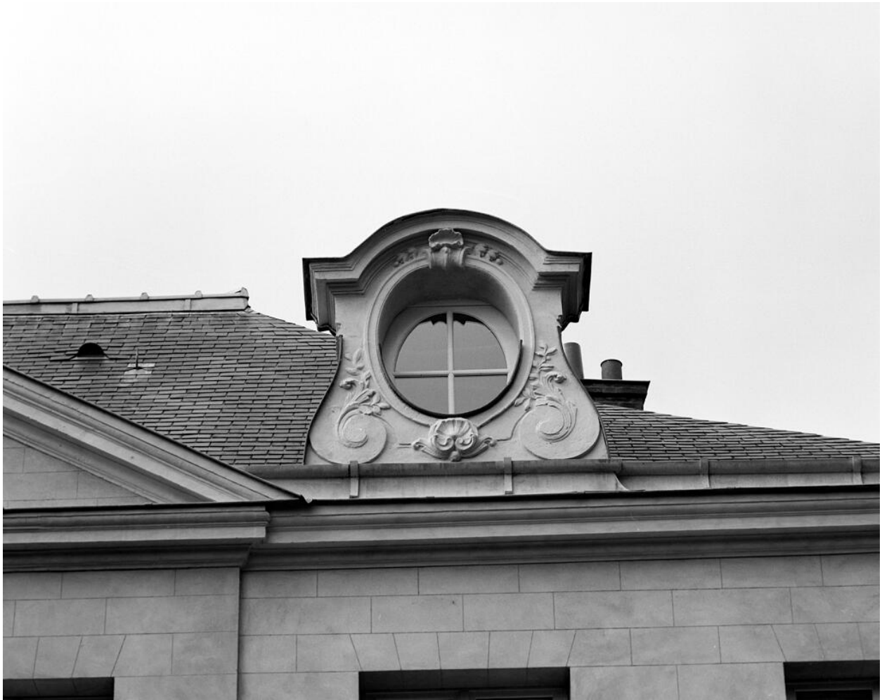
Détail d'une lucarne, façade sur jardin.
