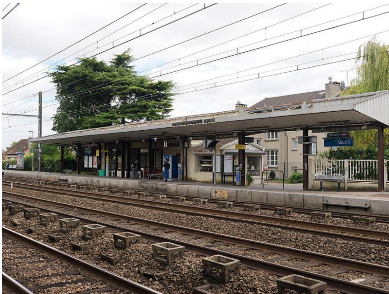
Ablon-sur-Seine, gare, place de la Libération. Vue d'ensemble de la gare: quais et voies.
