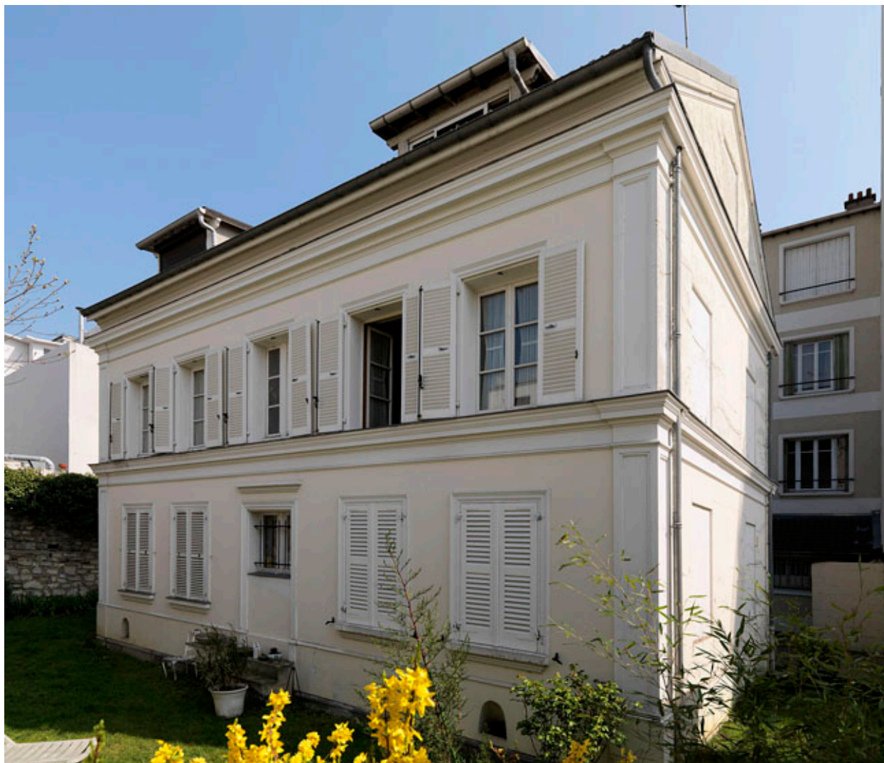
Vue en perspective façade postérieure et latérale.
