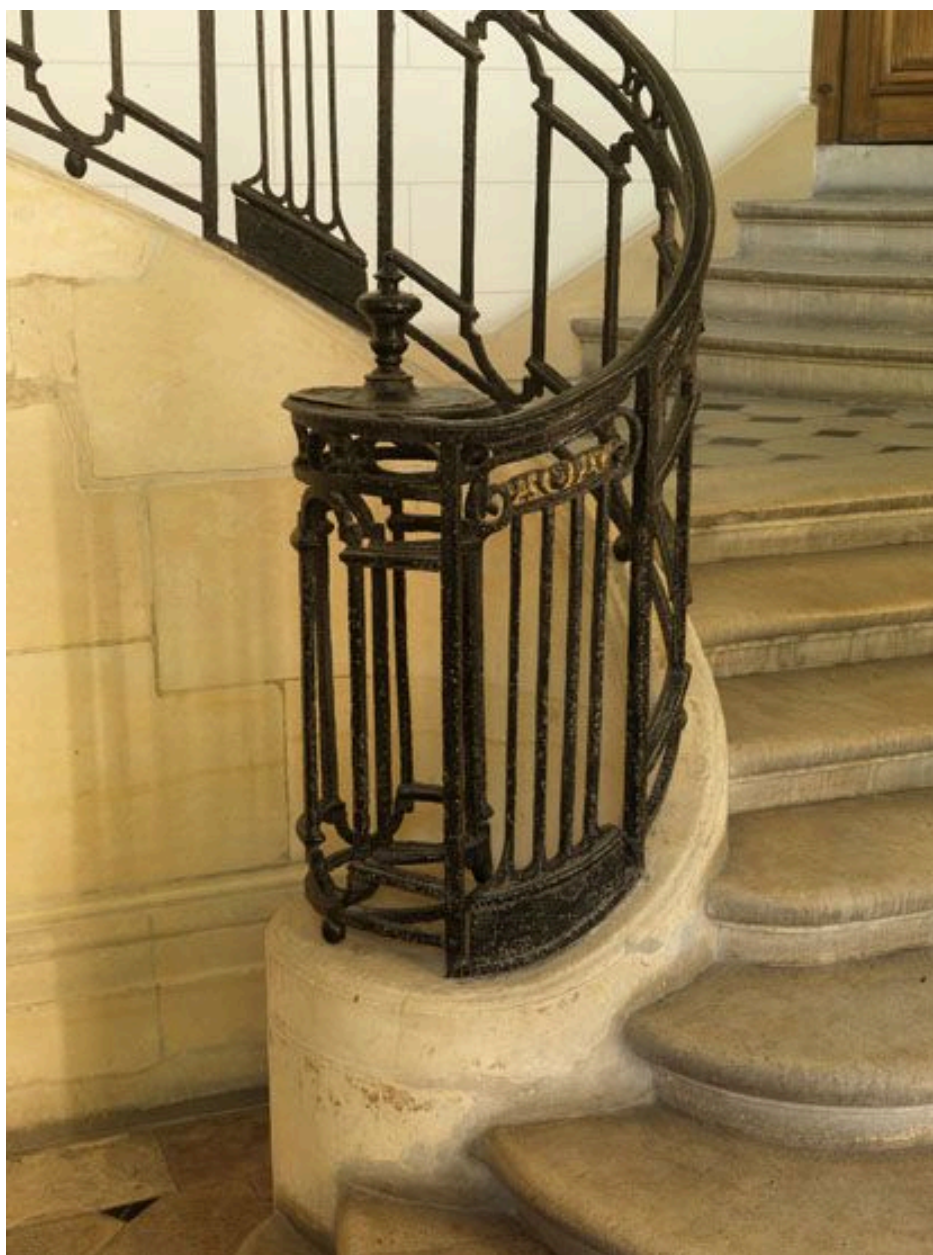
Le départ de la rampe.
