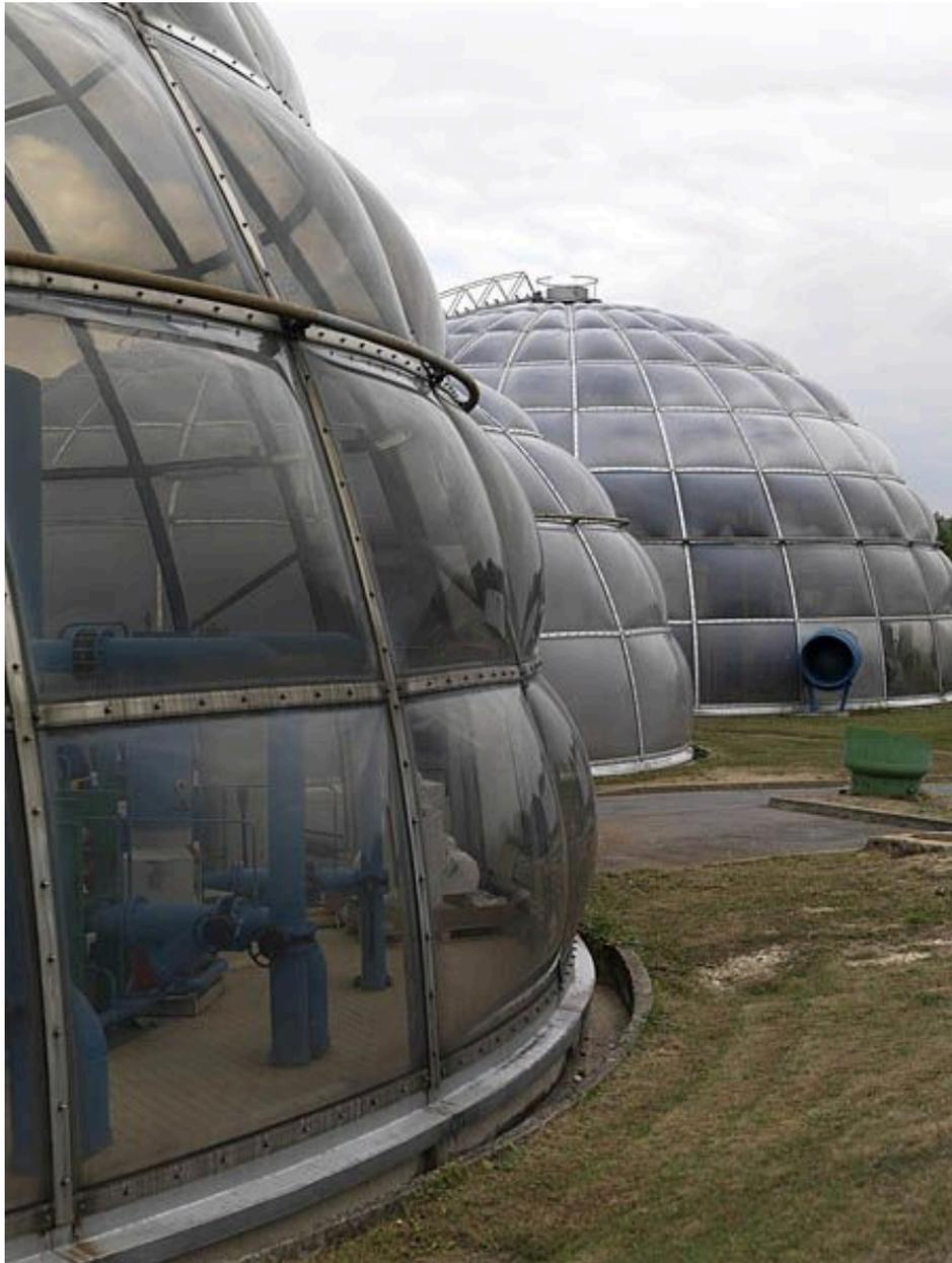
Gros plan sur les coupoles constituées de feuilles de polyméthacrylate de méthyle (plexiglas) coulé et posées sur des ossatures métalliques tubulaires. Vue des galettes autoportantes en béton qui constituent le sol formant ainsi des éléments monolithiques stables.
