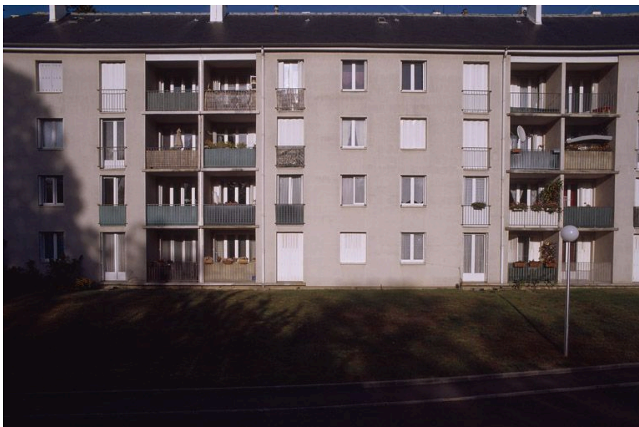
Façade arrière de l'immeuble n° 69 - 73 : travées centrales.
