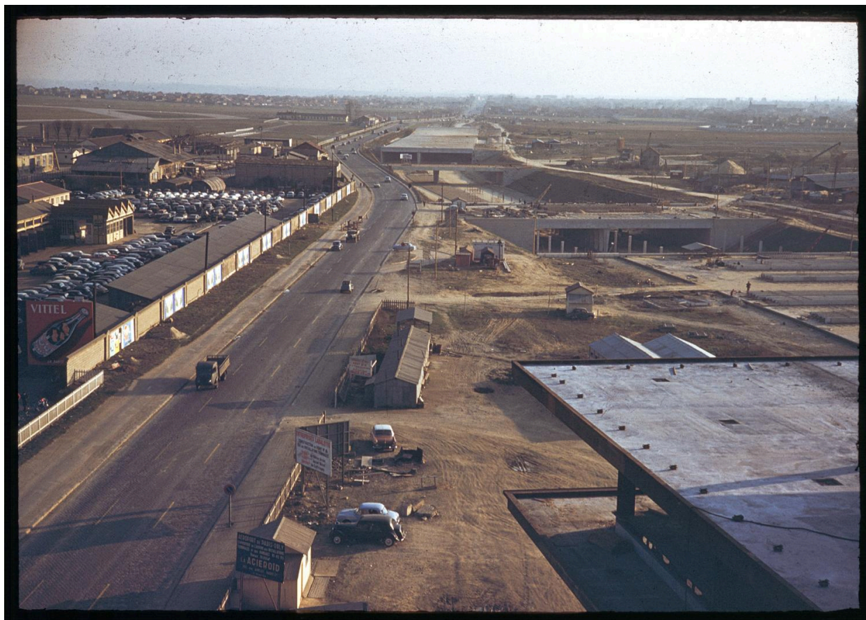
1956 1960 Construction du nouveau tracé de la Nationale 7, vue prise depuis l'angle nord est des terrasses des Installations terminales (Orly-Sud, Orly 4) en construction.
