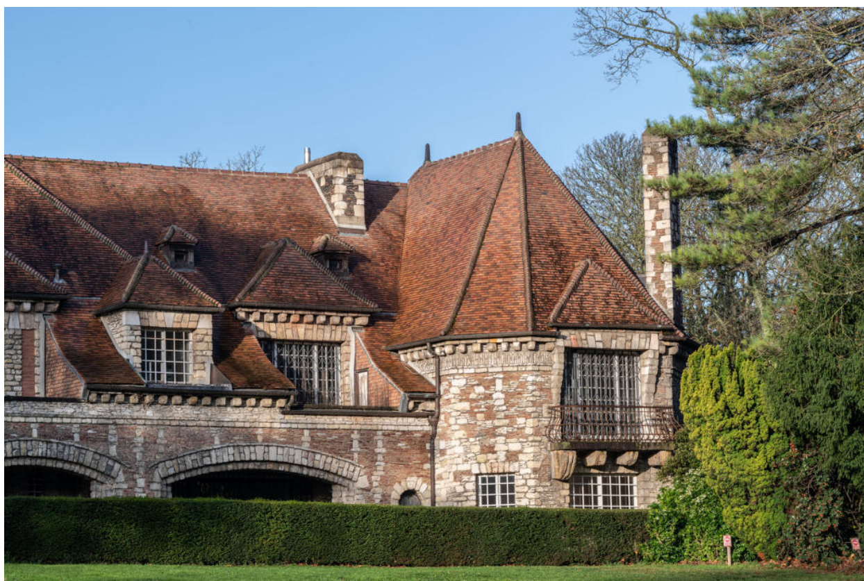
Villa des Tourneroches, vue de la façade orientale
