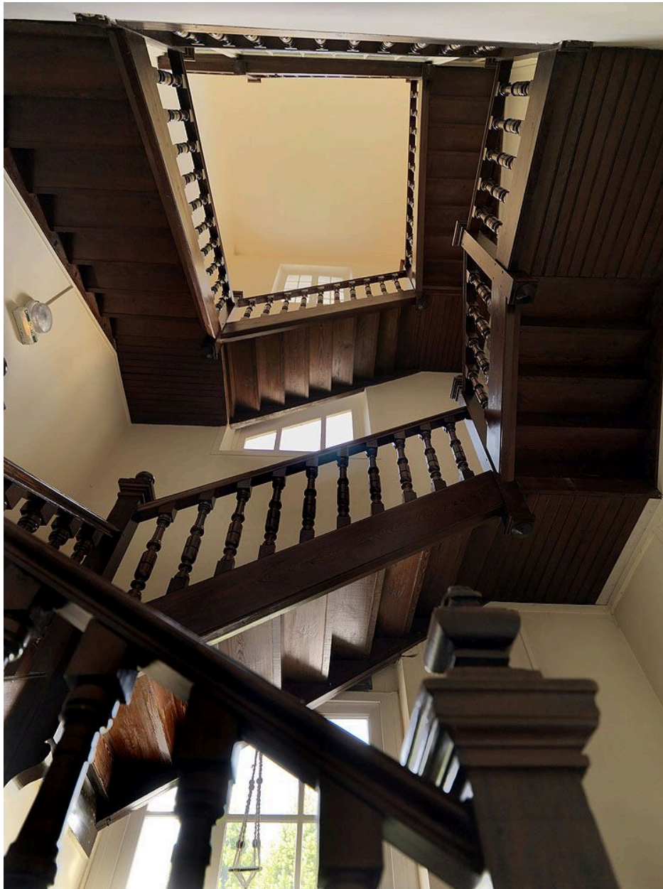
Escalier à balustres de bois, dans le pavillon d'entrée.
