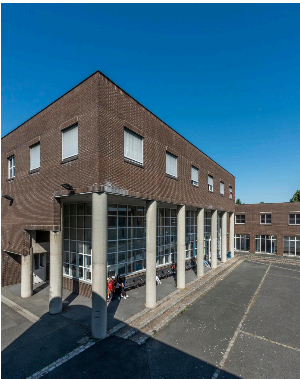
Le bâtiment central, avec sa grande verrière.
