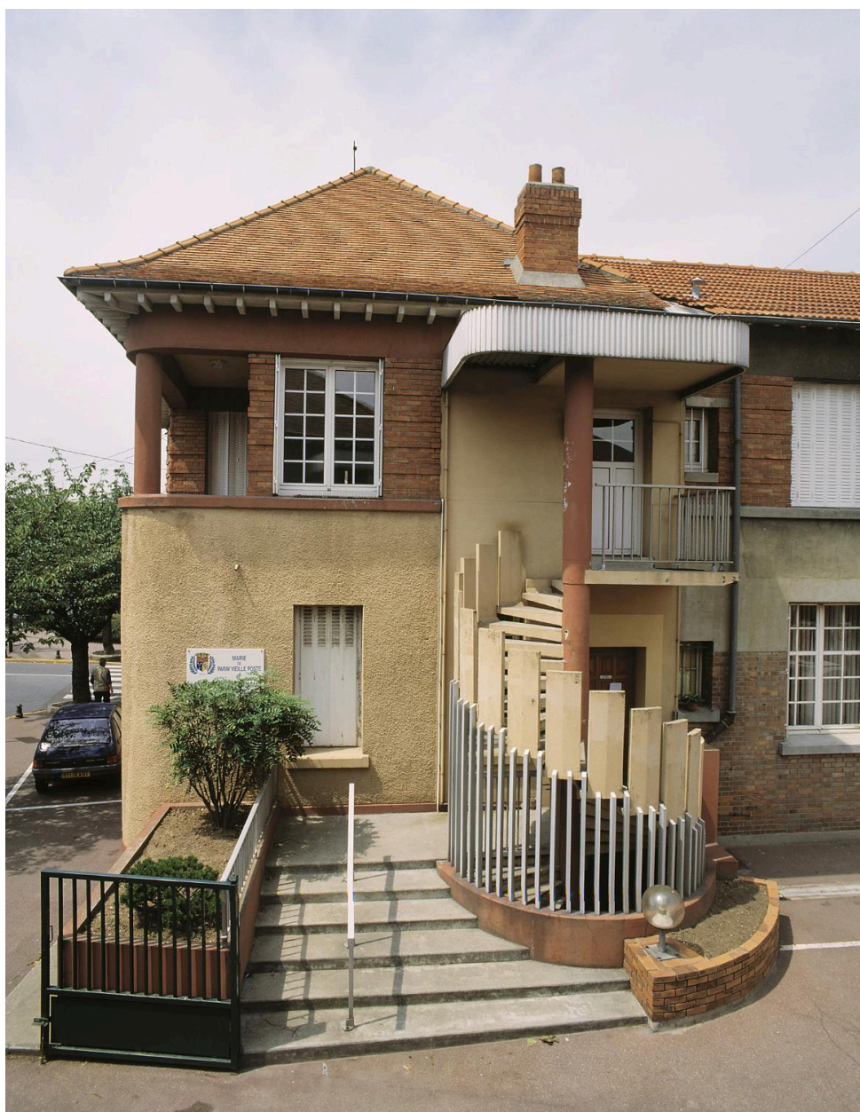
Façade latérale, sur la cour d'entrée, du pavillon de gauche.
