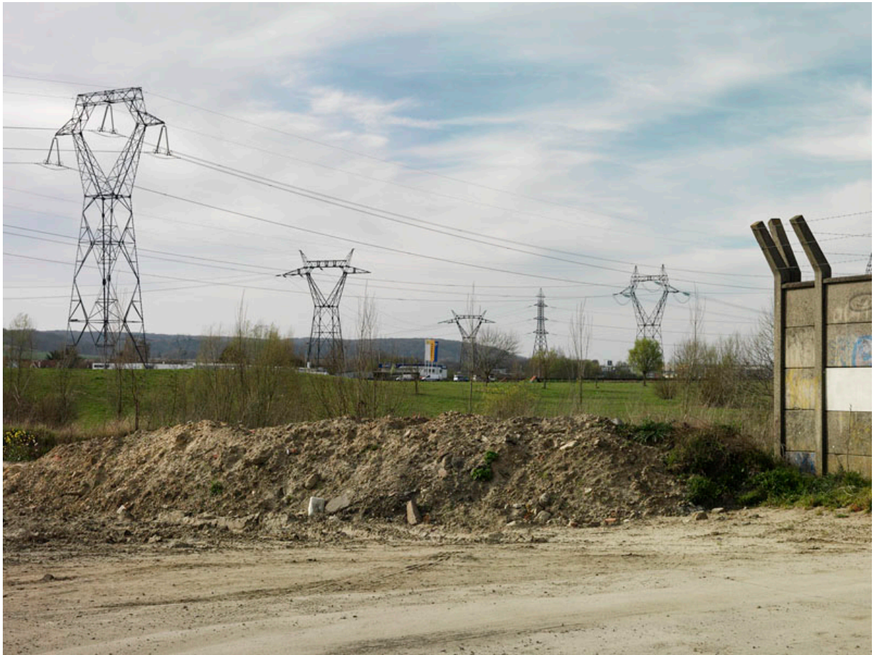
Persan. Autour de l'usine Hutchinson. Pylons électriques de ligne haute tension.
