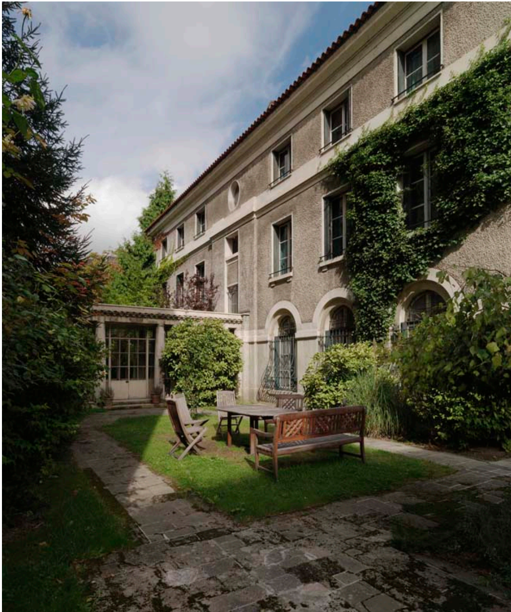
Vue du jardin intérieur, entre les deux pavillons.
