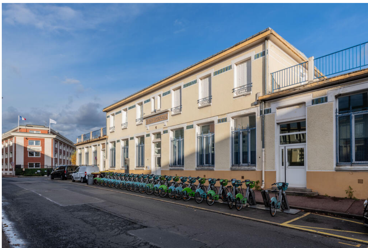
École des Coteaux, bâtiment de 1922, façade ouest
