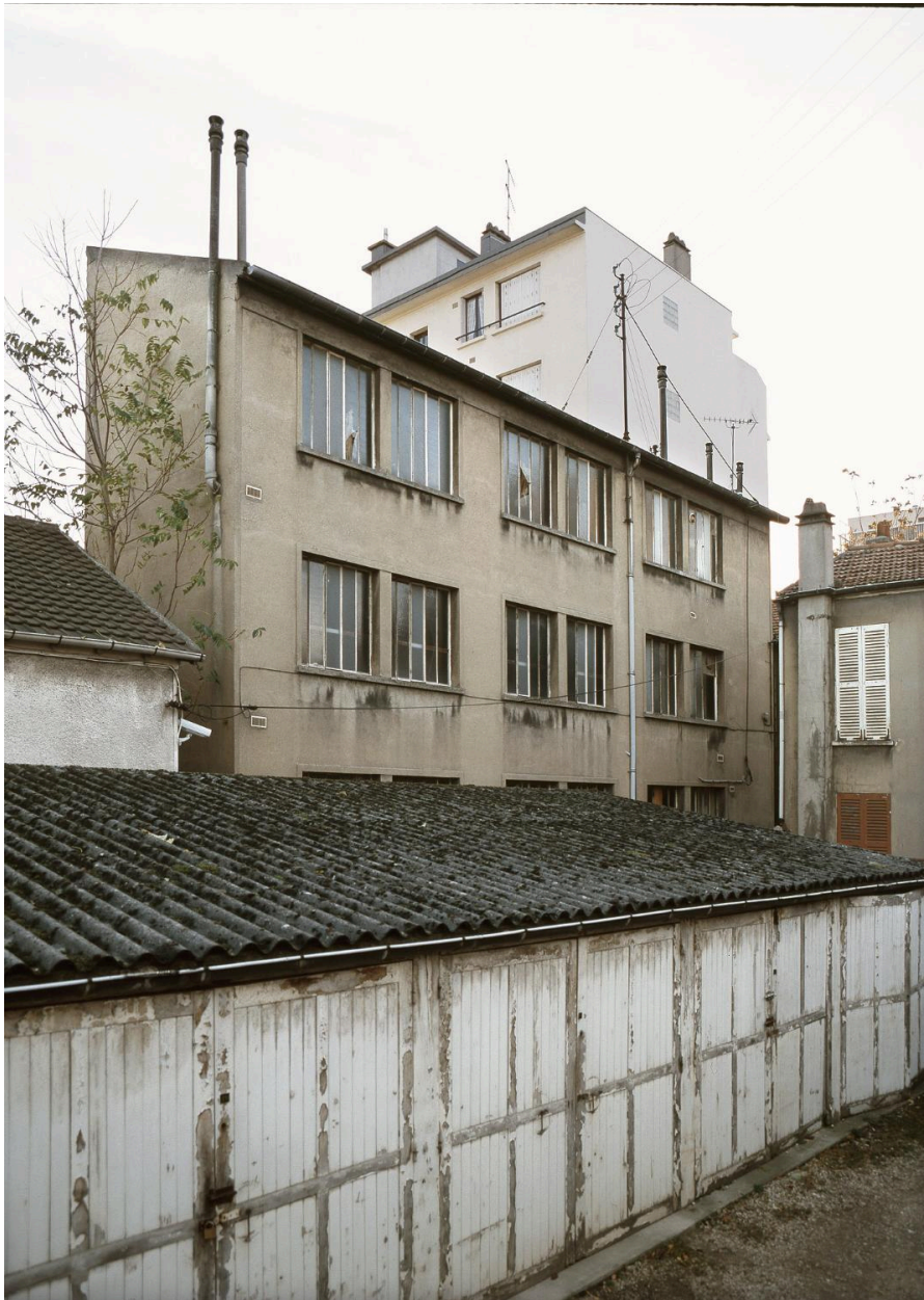
Façade de l'atelier principal.
