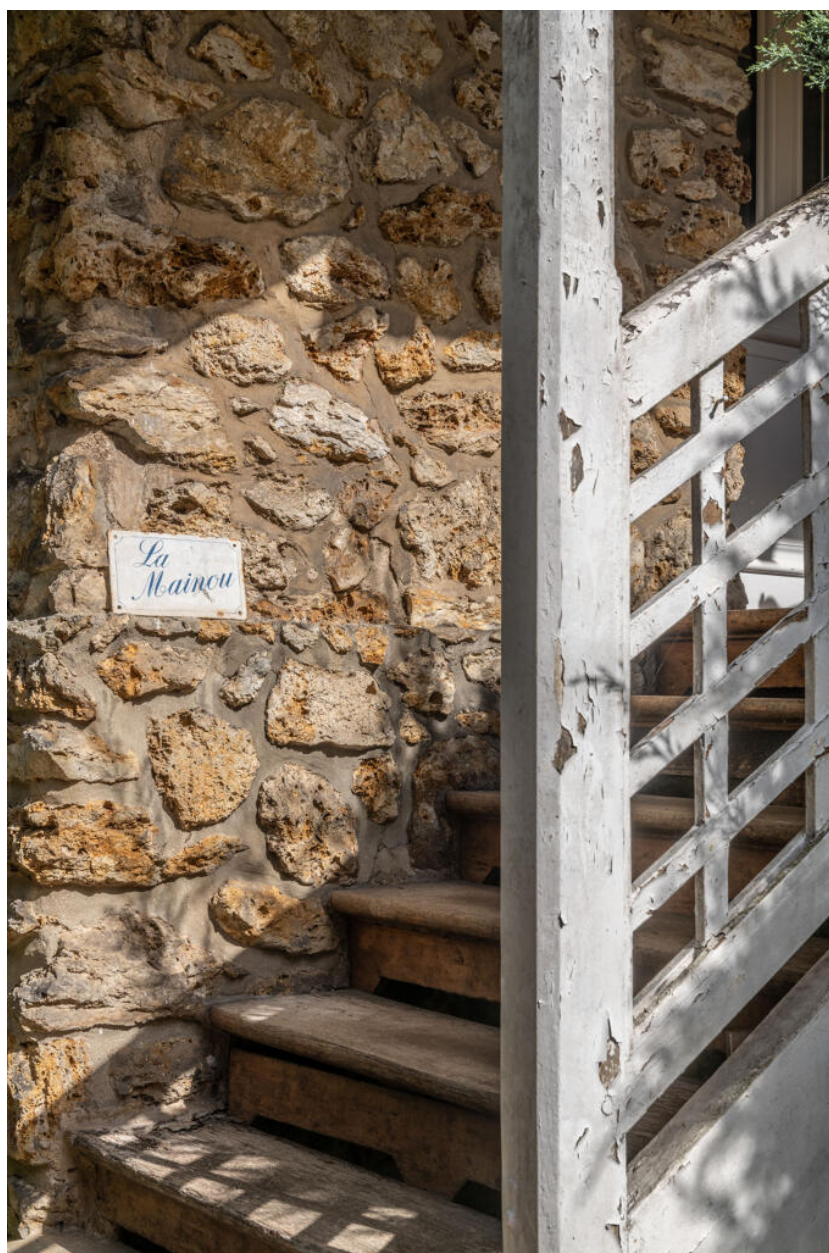
Détail de l'escalier du perron.
