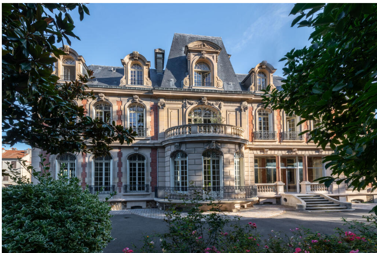
Vue générale de la façade sud.
