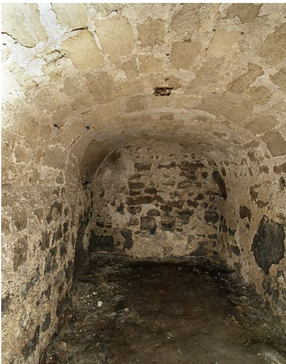
Alvéole donnant sur le cellier.
