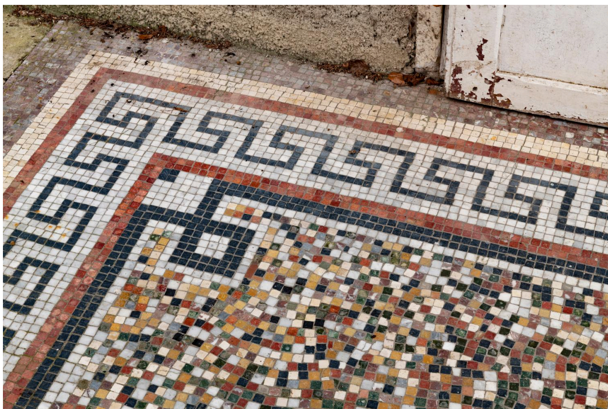
Mosaïque du palier extérieur de l'escalier d'entrée
