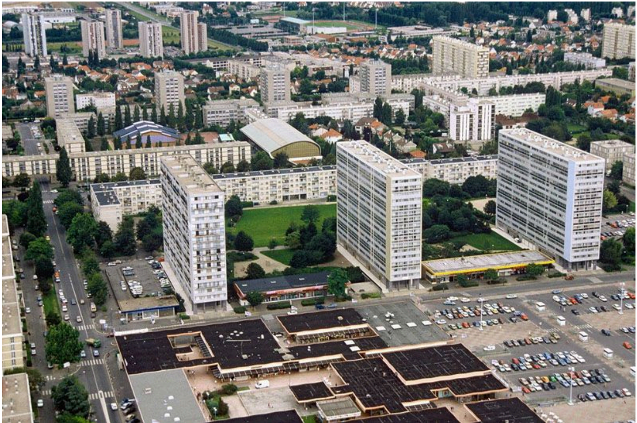
Vue aérienne de la place de France et du parc de la Corneille. Photographie, 01/06/1987. (Direction Régionale de l'Équipement Ile-de-France, 24117)
