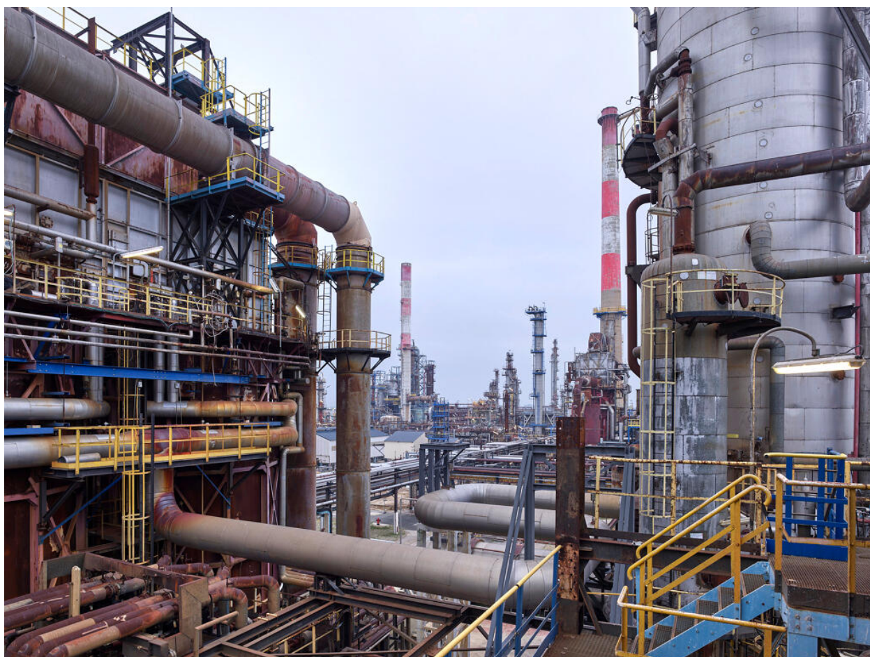
Unités Ouest - Zone de distillation (Unité 612). Vue générale avec à gauche le four 612 F1, à droite la colonne 612 C1 et au fond les Unités Est.
