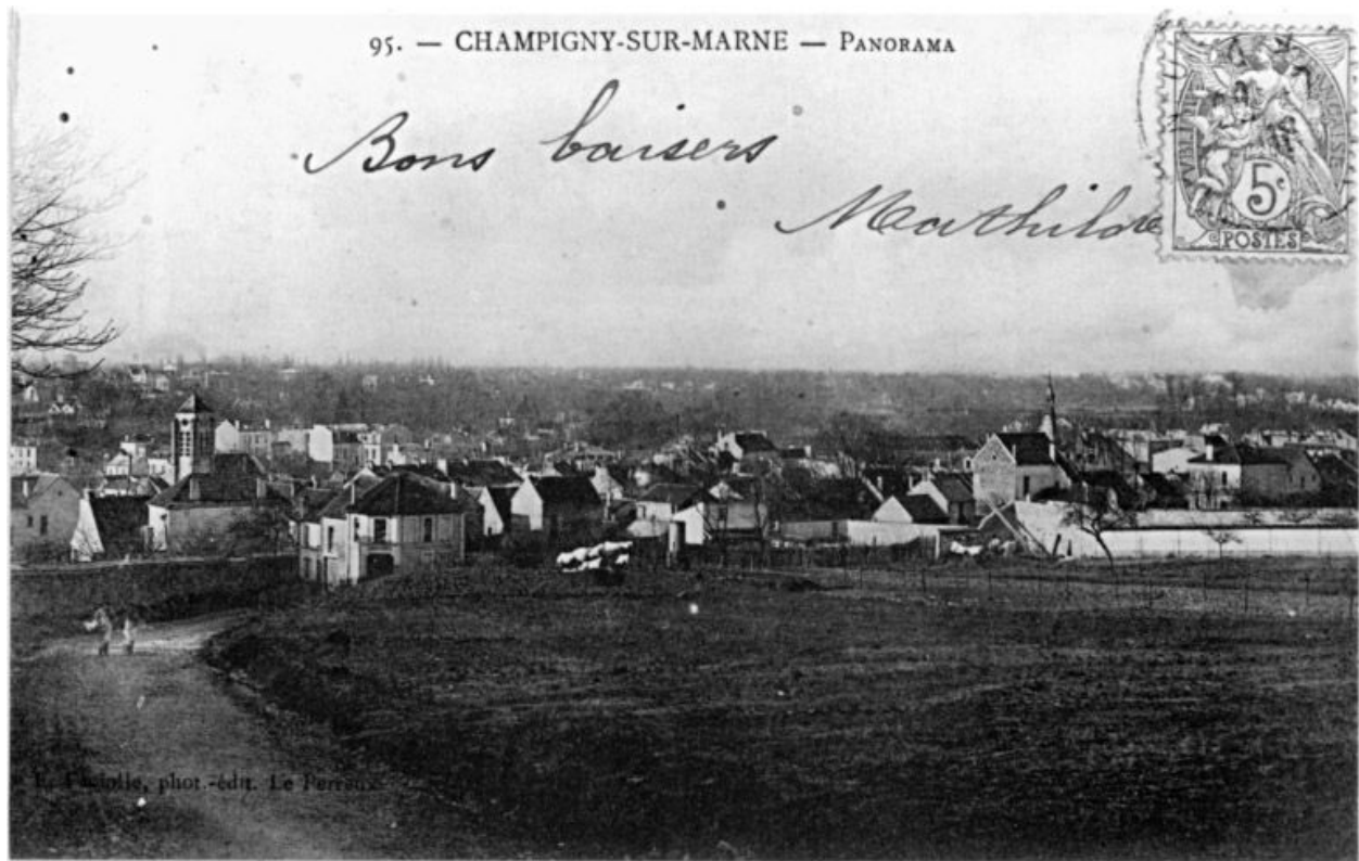
Vue panoramique prise du nord-est. Carte postale. (AD Val-de-Marne)
