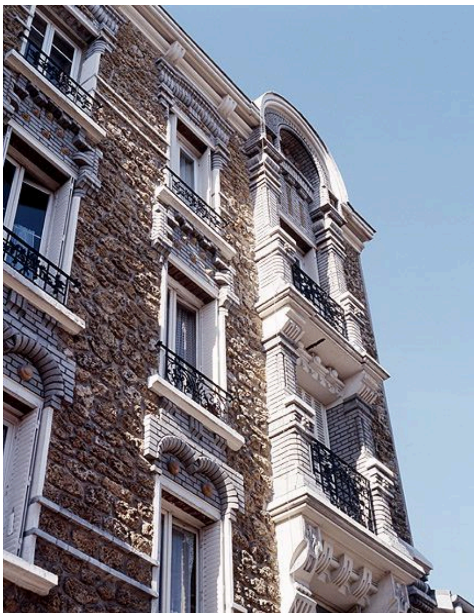
Immeuble, 15 rue Guy Moquet. Vue de la partie haute de la façade.
