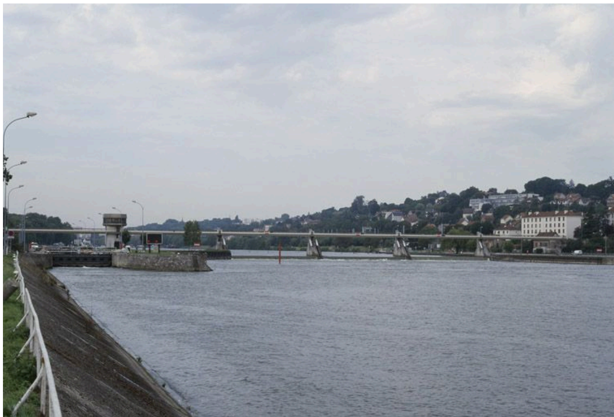
Vue du barrage d'Ablon (aval) ; à gauche, l'écluse de Vigneux.
