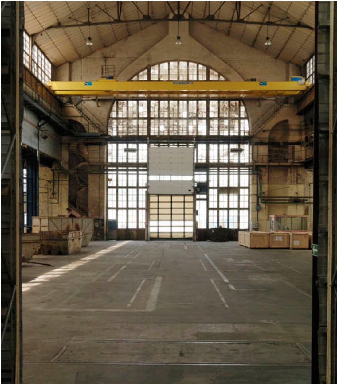
Vue intérieure de la nef centrale. Montage, machines-outils (1901-1903). Actuellement entreprise Jeumont Electric.
