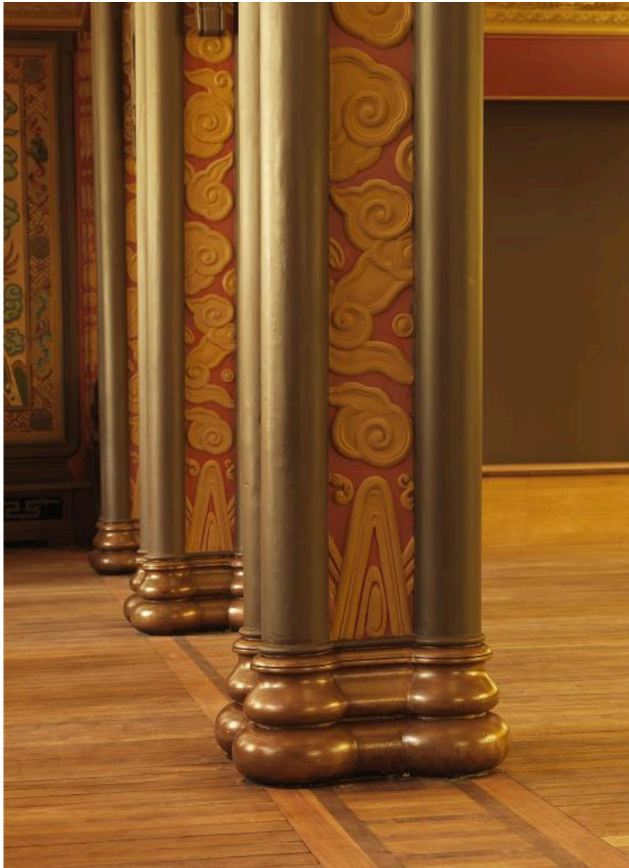
Le grand salon rénové en 2014 : détail des piliers.
