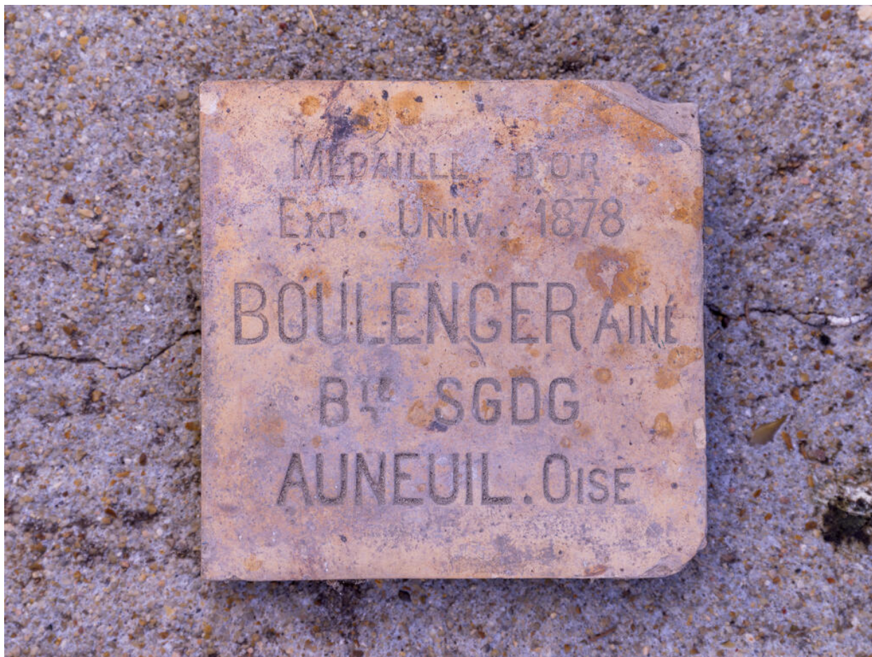
Vue de détail du dos d'un carreau de céramique composant le sol de la cage d'escalier.
