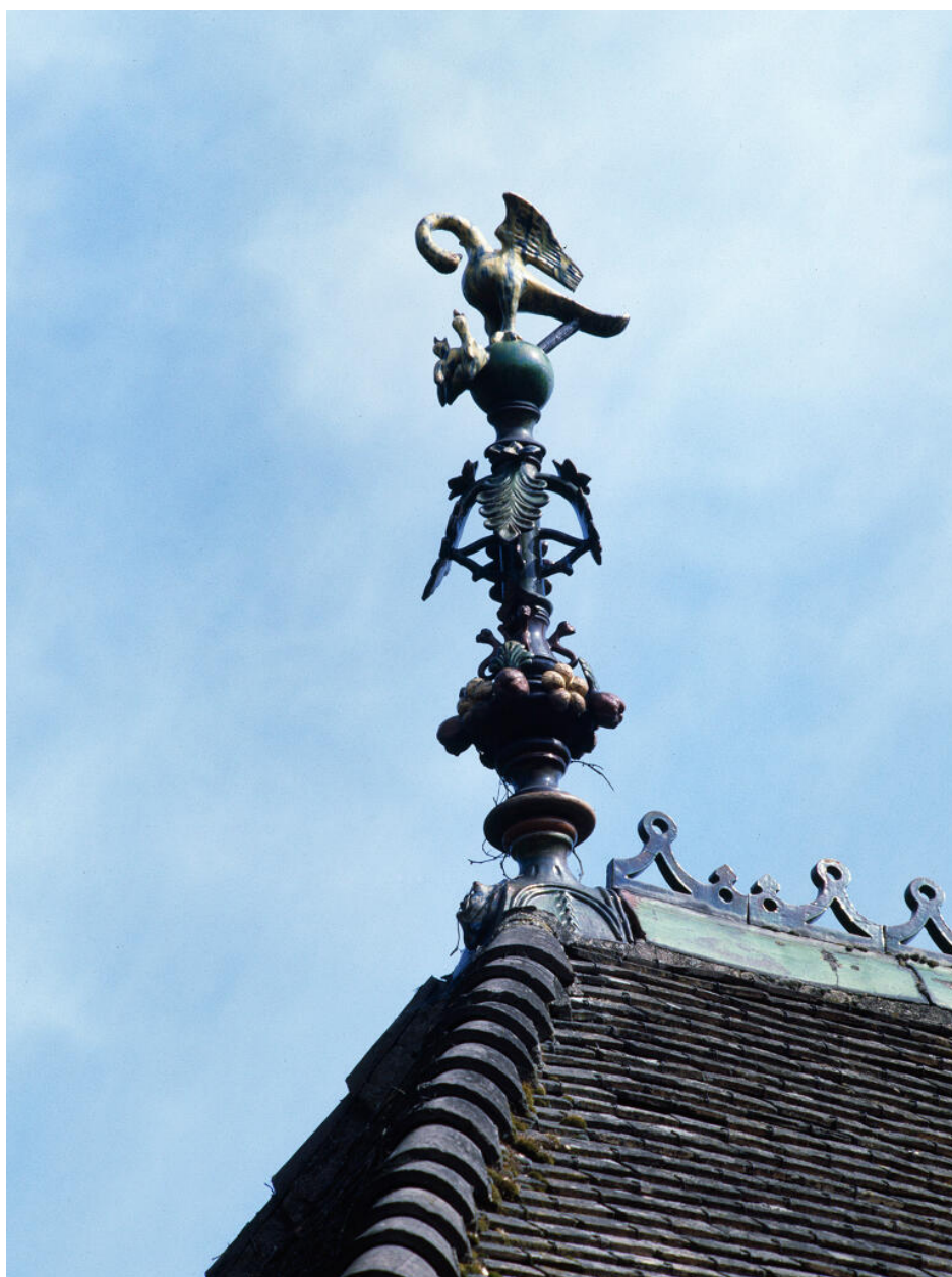
Vue d'un épi de faîtage.
