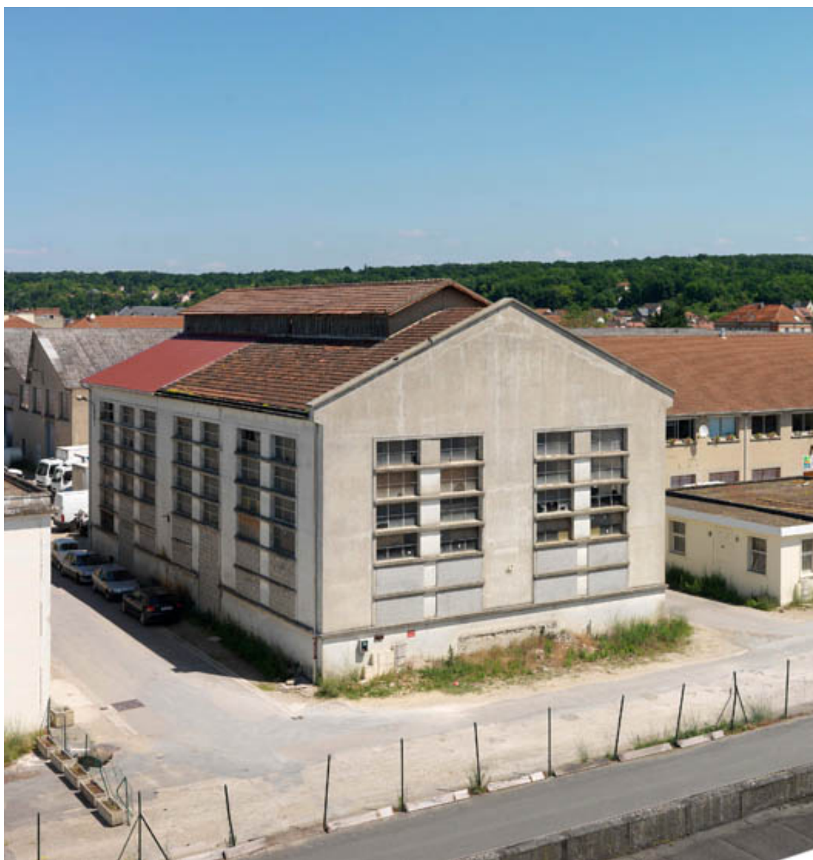
Vue extérieure. La chaufferie (1951).
