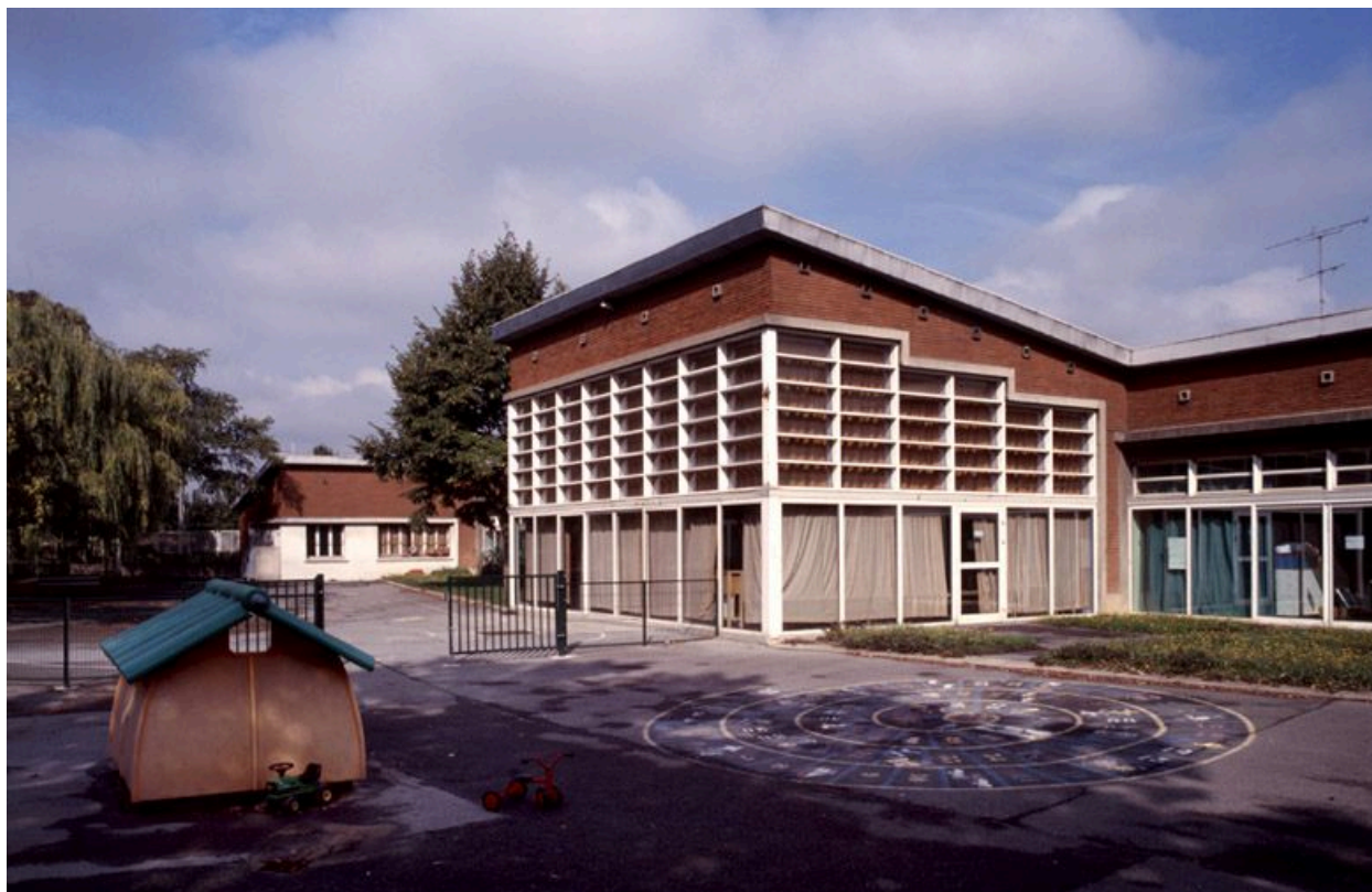
Groupe scolaire Joliot-Curie, rue Irène Joliot-Curie. Julien Heulot (architecte communal). Vue de la salle d'activités.
