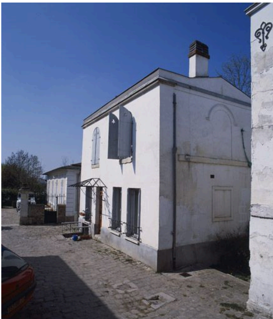
Maison située 37, rue Alphonse-Daudet, à l'arrière de la chapelle Sainte-Hélène : vue latérale.
