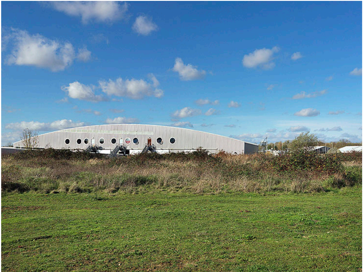
Le hangar à bateaux, vu de l'est.
