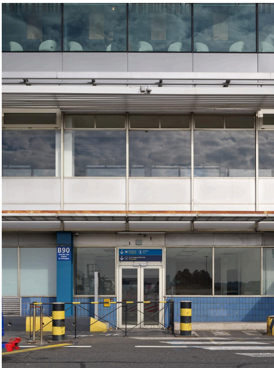
2018, Orly-Sud: ancienne salle d'embarquement de la jetée ouest vue depuis le sud.
