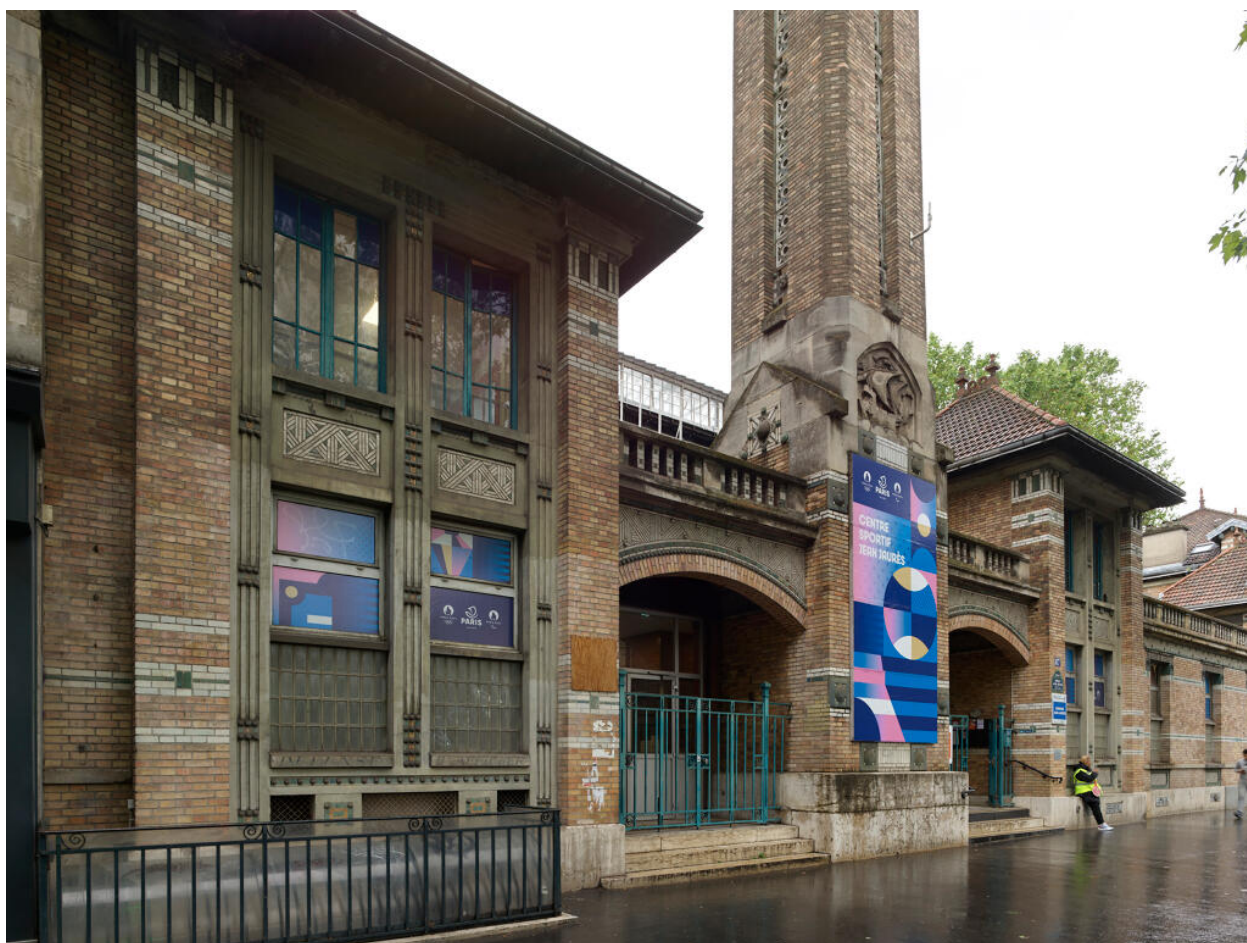
Le gymnase Jean Jaurès. Détail de l'entrée principale.
