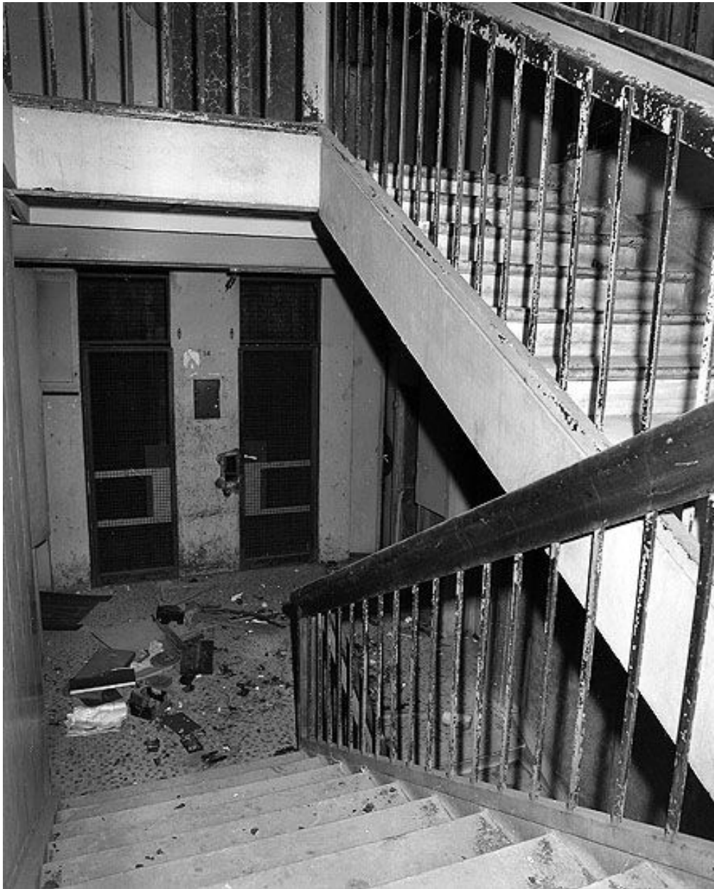
Tour 1, 14ème étage, cage d'escalier. Campagne photographique, lors de la destruction du bâtiment en 1976.
