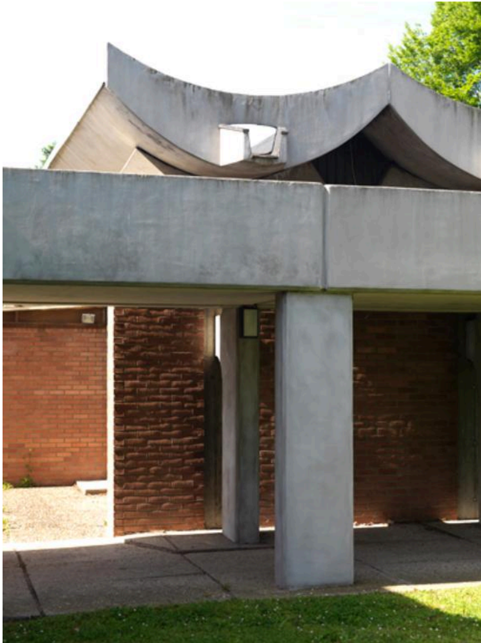
Autre détail d'une galerie faisant office de chéneau monumental.
