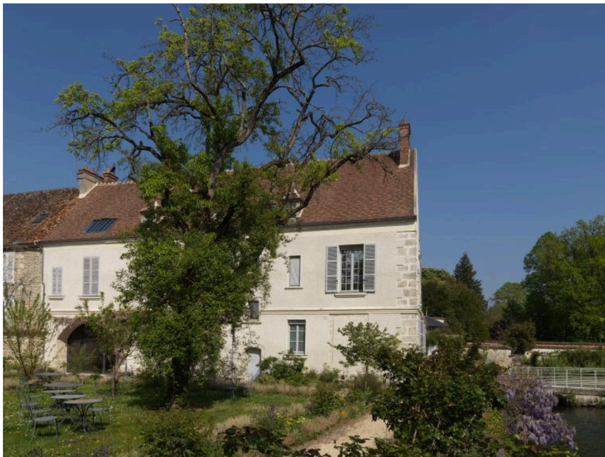
Vue de la façade postérieure du bâtiment principal (1)
