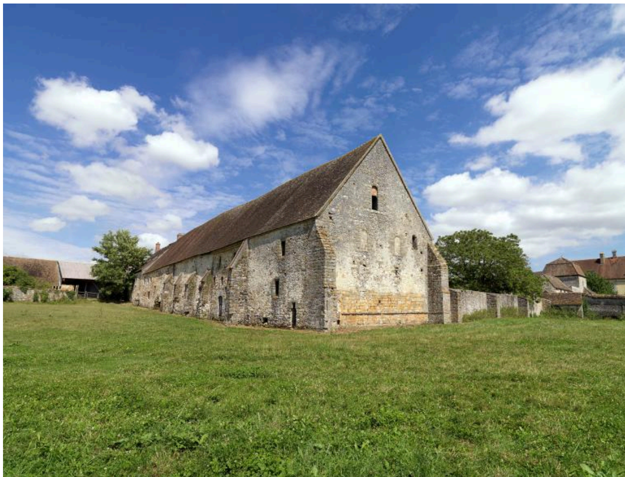
Vue sur le mur pignon sud et sur la façade ouest de la grange des Beauvais.
