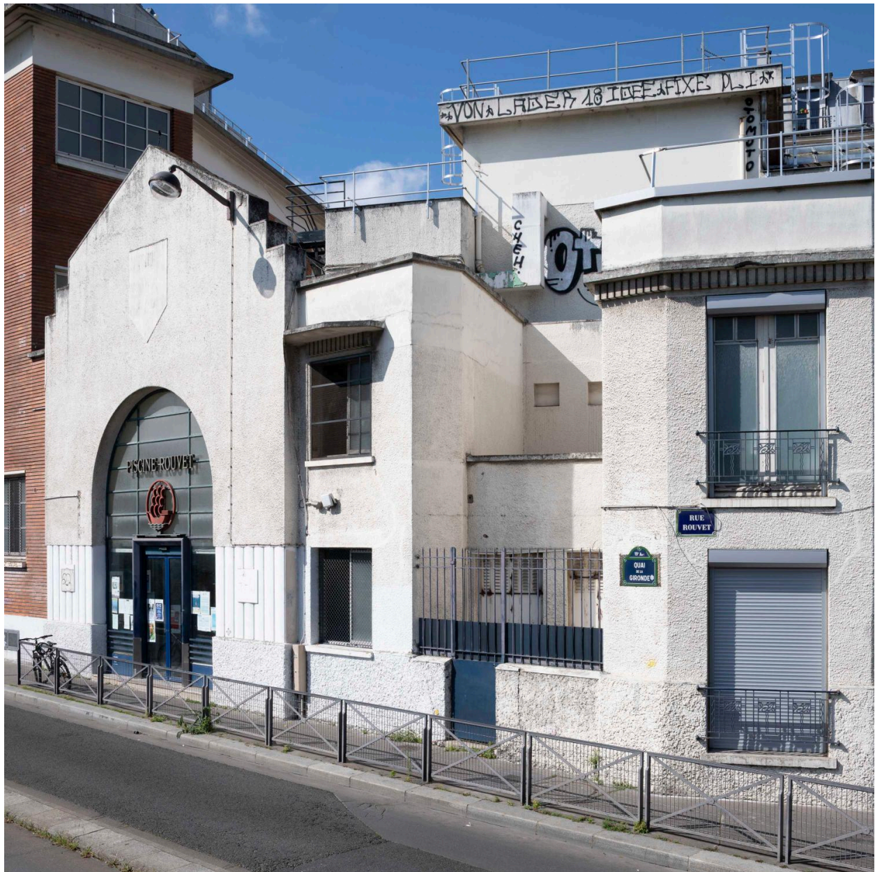
Elévations sur rue de la piscine Rouvet comprenant l'entrée principale et le logement du gardien.
