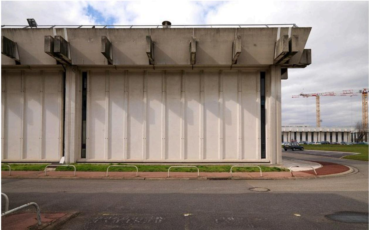
Rungis, ensemble industriel et commercial dite zone SILIC. Vue rapprochée de la structure béton et de la toiture terrasse composée d'éléments préfabriqués.
