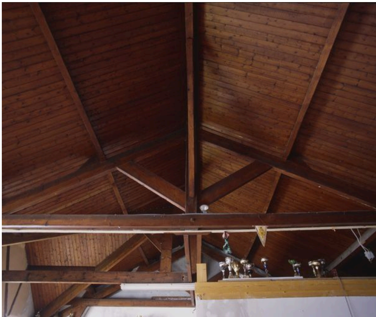
Vue intérieure de la charpente lambrissée du club-house.
