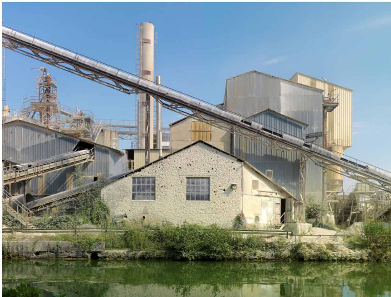
Vue extérieure depuis le canal du Loing.
